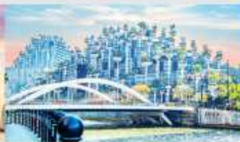
อาคารฟันทันไม้
