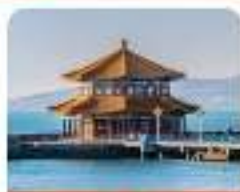
สะพานจางเจียว
